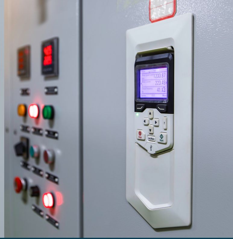
Emergency Diesel Generator مولدات للطاقة الاحتياطية
